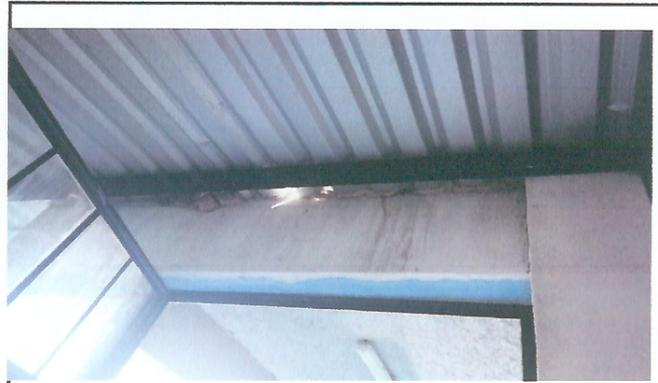
**Foto 2: Mejoramiento de estructura tipo portico e instalacion de lamina troquelada calibre 16**
